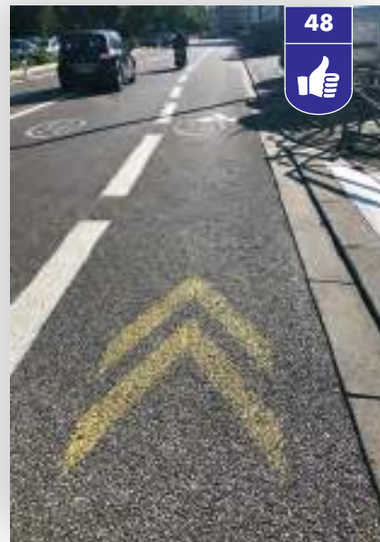
Mise en service définitif d'une ancienne "Tempo vélo".
