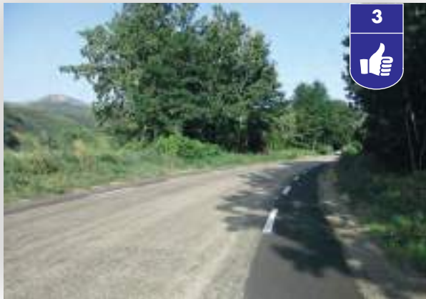
Il peut aussi y avoir deux revêtements différents : lisse pour les cyclistes, plus granuleux pour les autres utilisateurs de la chaussée.
