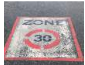
Marquage d'entrée en " Zone 30 ".
